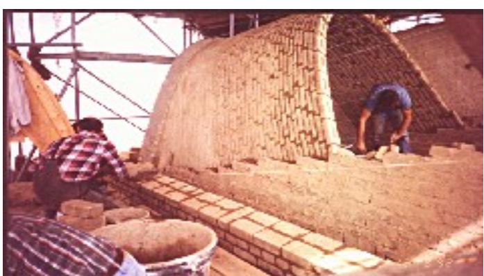
MAUERN DER NUBISCHEN GEWÖLBE
